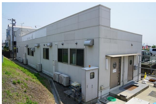
<旧給食センターを改修した食肉処理施設>
