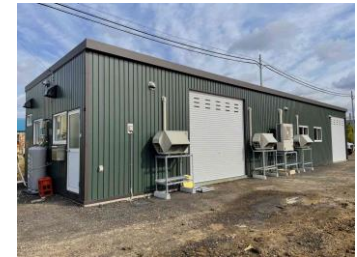
<処理施設の外観>
