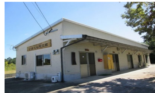
< 処理施設の外観 >
