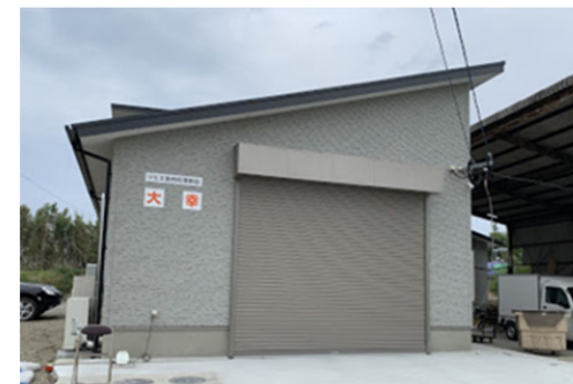
＜処理施設の外観＞
