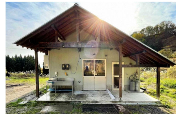
<処理施設の外観>
