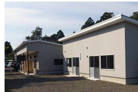
<処理施設の外観>
