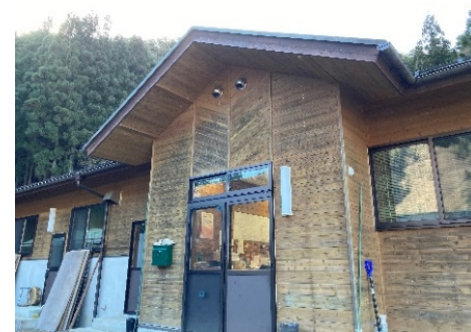
<処理施設の外観>
