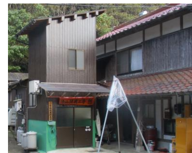
<処理施設の外観>
