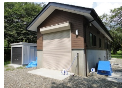
<処理施設の外観>
