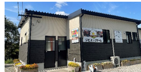
<処理施設の外観>
