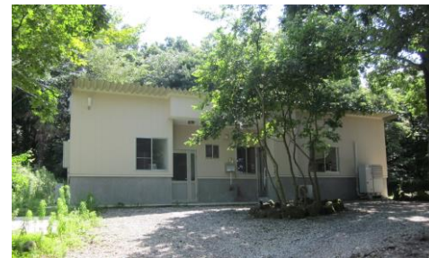
<処理施設の外観>
