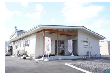
<処理施設の外観>
