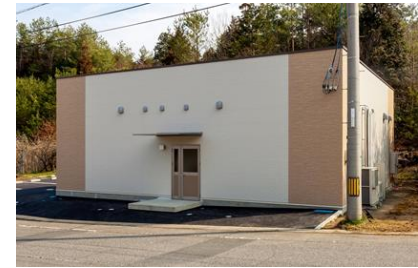
<処理施設の外観>
