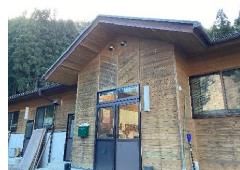
＜処理施設の外観＞
