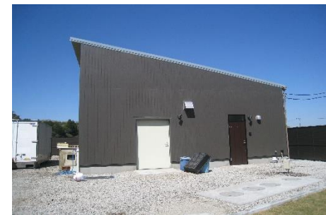
＜処理施設の外観＞
