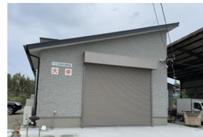
＜処理施設の外観＞
