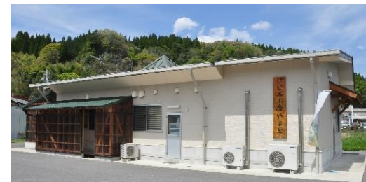
<処理施設の外観>
