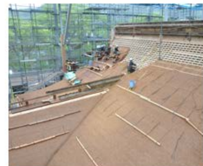
<建造物維持修理の様子> 重要文化財 大宰府天満宮本殿 屋根葺替え(福岡県)
