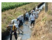
水路の泥上げ
