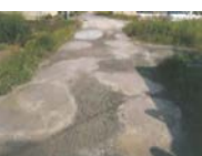
農道の窪みの補修
