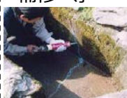
水路のひび割れ補修
