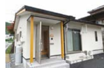
空き家の改修（お試し居住施設）
