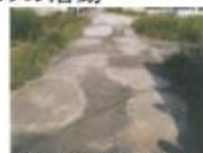
農道の窪みの補修
