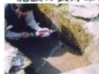
水路のひび割れ補修
