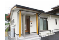
空き家の改修 (お試し居住施設)
