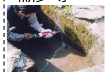
水路のひび割れ補修
