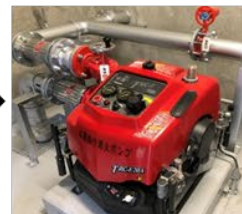
老朽化した消火ポンプの更新
