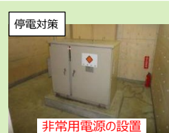
非常用電源の設置
