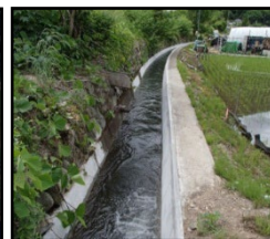
老朽化した用水路の整備・更新
