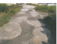
農道の窪みの補修
