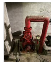
老朽化した消火ポンプの更新
