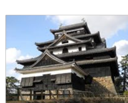
松江城天守の木製格子壁による補強
