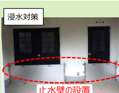
止水壁の設置
