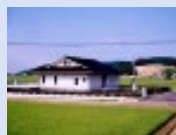
農業集落排水施設
