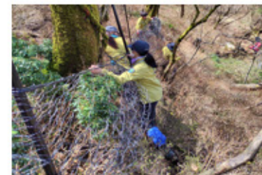
■ シカ柵の設置
