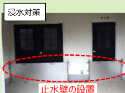
止水壁の設置
