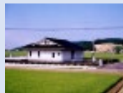
農業集落排水施設
