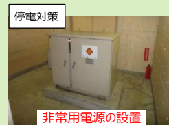
非常用電源の設置
