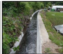
老朽化した用水路の整備・更新
