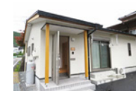
空き家の改修 (お試し居住施設)
