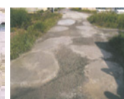
農道の窪みの補修
