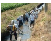
水路の泥上げ
