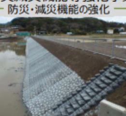
ため池護岸の整備
