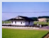
農業集落排水施設
