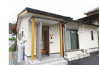
空き家の改修 (お試し居住施設)
