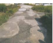
農道の窪みの補修
