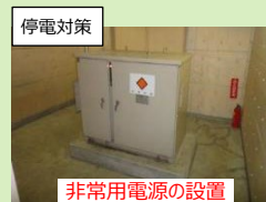
非常用電源の設置
