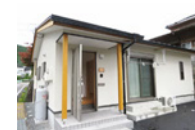
空き家の改修 (お試し居住施設)
