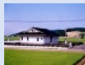
農業集落排水施設
