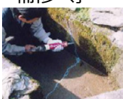
水路のひび割れ補修
