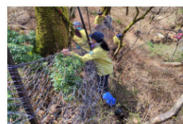
■ シカ柵の設置
