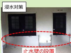
止水壁の設置
