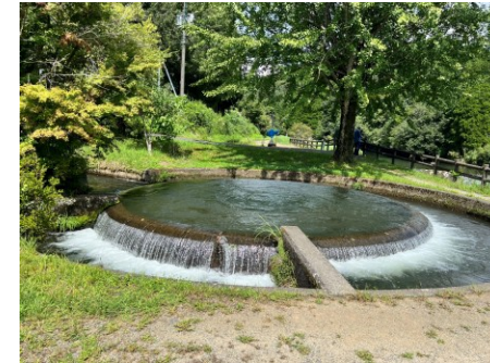
通潤橋へ水を送る円形分水
