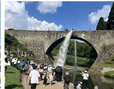
国宝 通潤橋の放水
