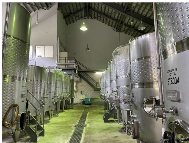
奥尻ワイナリーの工場内
