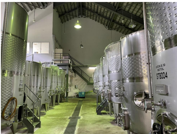
奥尻ワイナリーの工場内
