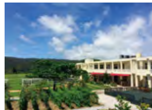
旧小中学校を改装した施設
