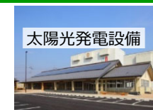
太陽光発電設備
