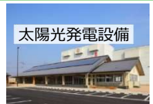
太陽光発電設備
