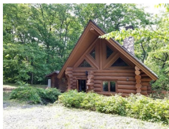
空き家を改修した宿泊施設
