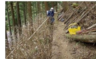
ミツマタ群生地遊歩道整備
