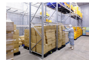
輸出を可能にした大型冷蔵設備
