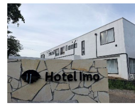
遊休施設を活用したホテル
