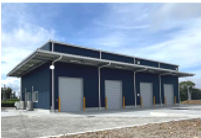
整備された貯蔵庫・出荷施設
