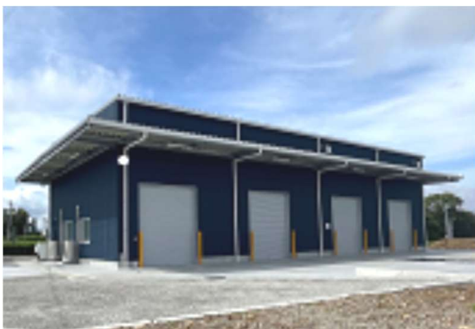
整備された貯蔵庫・出荷施設
