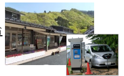
EV車等への給電設備
