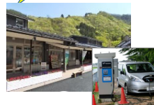
EV車等への給電設備
