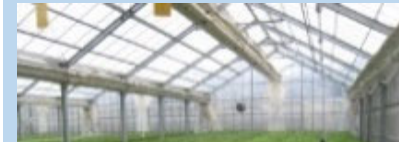
障害者等が作業に携わる生産施設の整備
