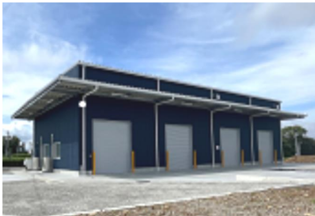
整備された貯蔵庫・出荷施設
