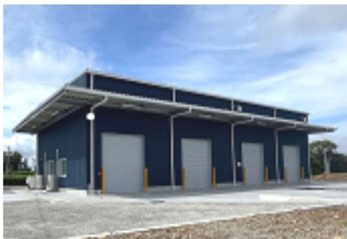
整備された貯蔵庫・出荷施設
