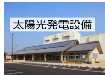
太陽光発電設備
