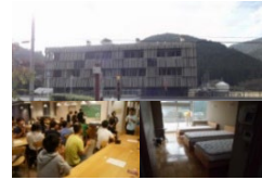
廃校を利用した交流施設
