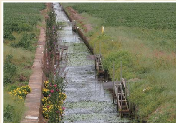
水路に設置された魚道
