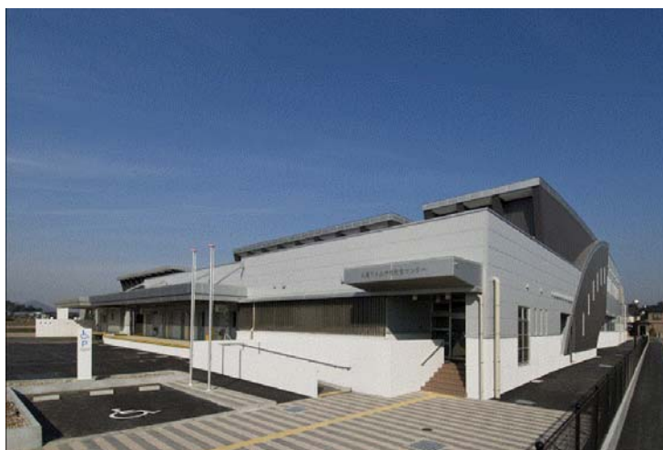
丸亀市中央学校給食センター
