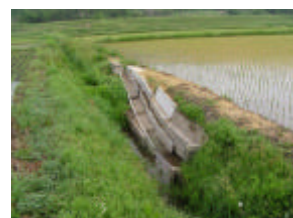
東和地区1 コンクリート2次製品 (廃材利用)
