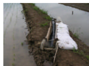
東和地区2 電線管 (ポリエチレン製)
